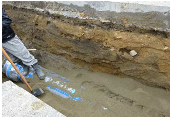
送水管 NSφ400 L=303.46m(301.90m) 布設状況写真
