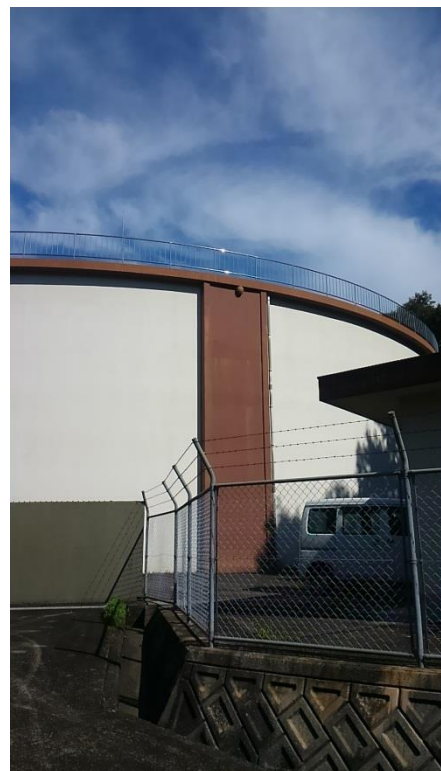
笠岡西配水池
