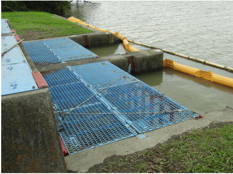
高梁川 取水口
